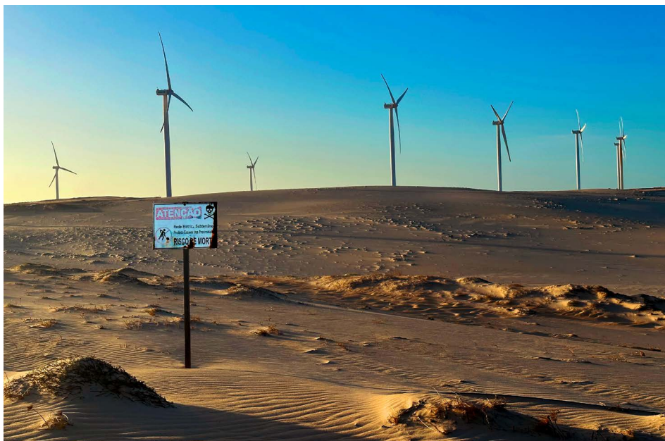
Según los entrevistados, el peligro de los cables eléctricos hace imposible circular por la zona ocupada por las plantas, los molinos de viento de la foto están situados en Quilombo do Cumbe, Aracati. Foto: Instituto Terramar
